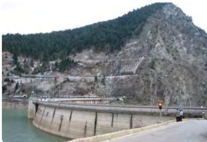
Φράγμα Ταυρωπού (Ν. Καρδίτσας).
