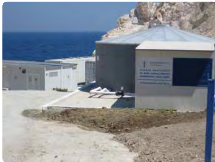
Μονάδα αφαλάτωσης στη Μήλο.
