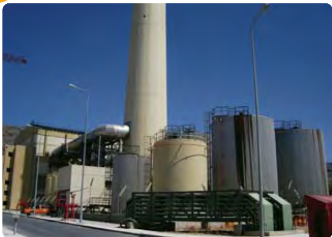
Ο σταθμός της Δ.Ε.Η. στον Αθερινόλακο Κρήτης λειτουργεί με πετρέλαιο.
