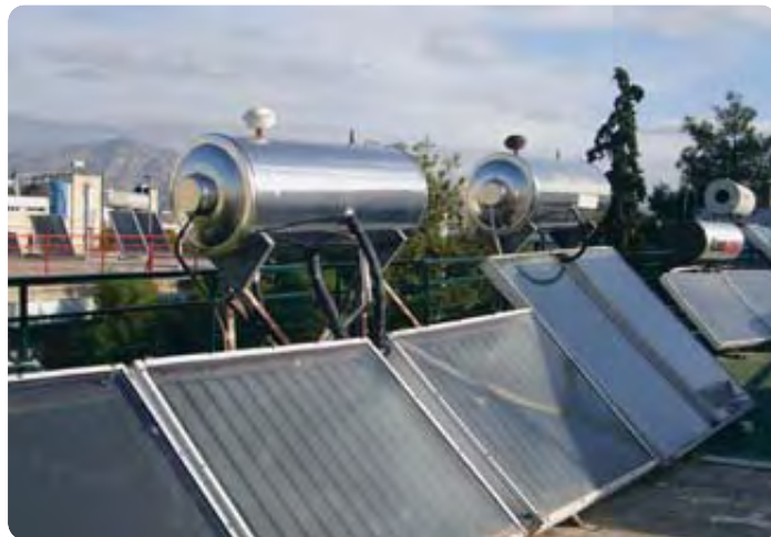
Ηλιακοί θερμοσίφωνες σε ταράτσα πολυκατοικίας.
