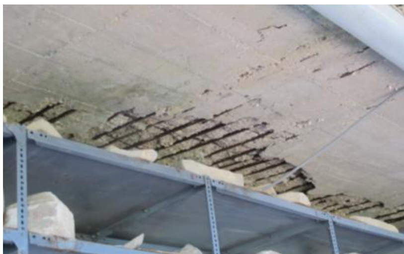
Εικόνα 9.3 Αποφλοιώση και αποκόλληση των δομικών υλικών στο Μουσείο Ελευσίνας, 2016. (Πηγή: Προσωπικό αρχείο)
