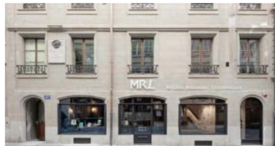
Εικ. 2: Άποψη της πρόσοψης του MRL στην οδό 40 Grand-Rue, αναρτημένη αναμνηστική πλάκα με προτομή του Ρουσσώ σε μετάλλιο και επιγραφή ανακατασκευής πρόσοψης
