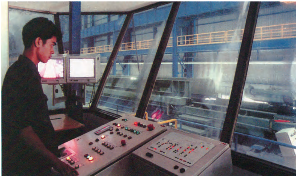
Σχήμα 3.10: Τράπεζα χειρισμών εγκατάστασης αυτοματισμού.
