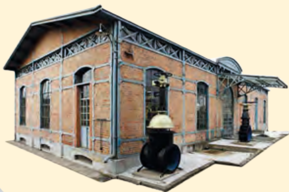
Αντλιοστάσιο της Οθωμανικής Εταιρείας Υδάτων (1890-1894), σήμερα Μουσείο Ύδρευσης, Θεσσαλονίκη.
